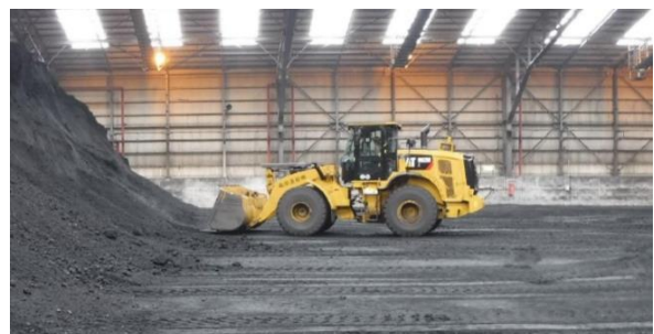
発電所での作業の様子
